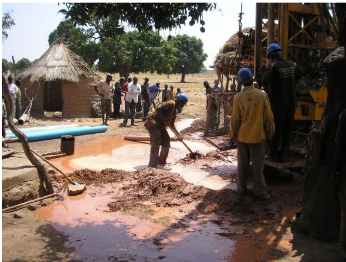
On s'affaire au forage du puits à Nianfala. (Photo : Courtoisie)
