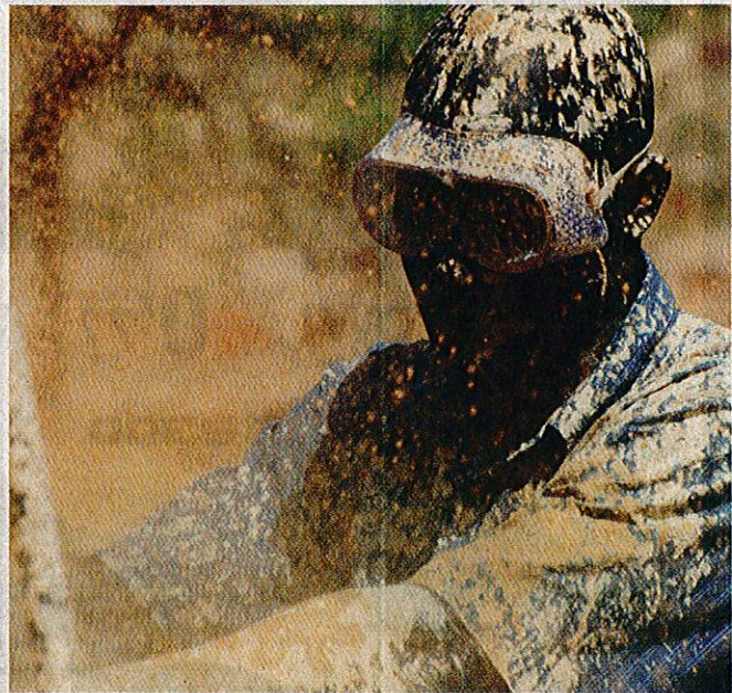
Les foreurs ont repris les travaux dans le village de Dandoli, alors que l'eau a jailli. (Photo : Kevin Riopel)
